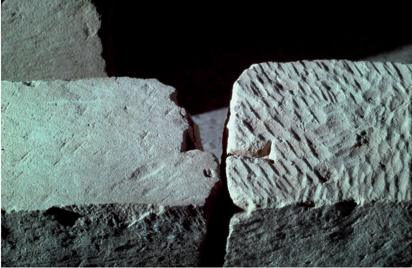
Figura 6. Huellas de instrumentos especializados utilizados para labrar los sillares (Foto MAG).
